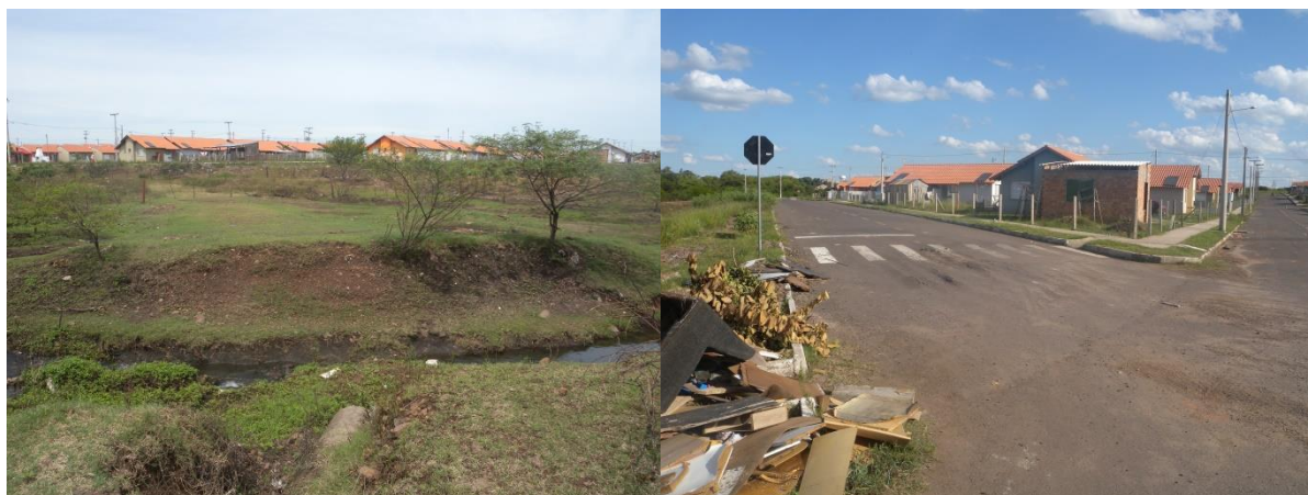
Figura 53 - Loteamento construído junto a área plana do rio (a) e área afetada em 2015 (b).
