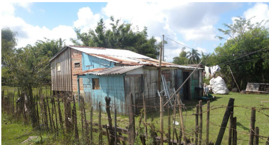
Figura 46 - Residência próxima ao rio e afetada no bairro Rui Ramos, risco muito alto.
