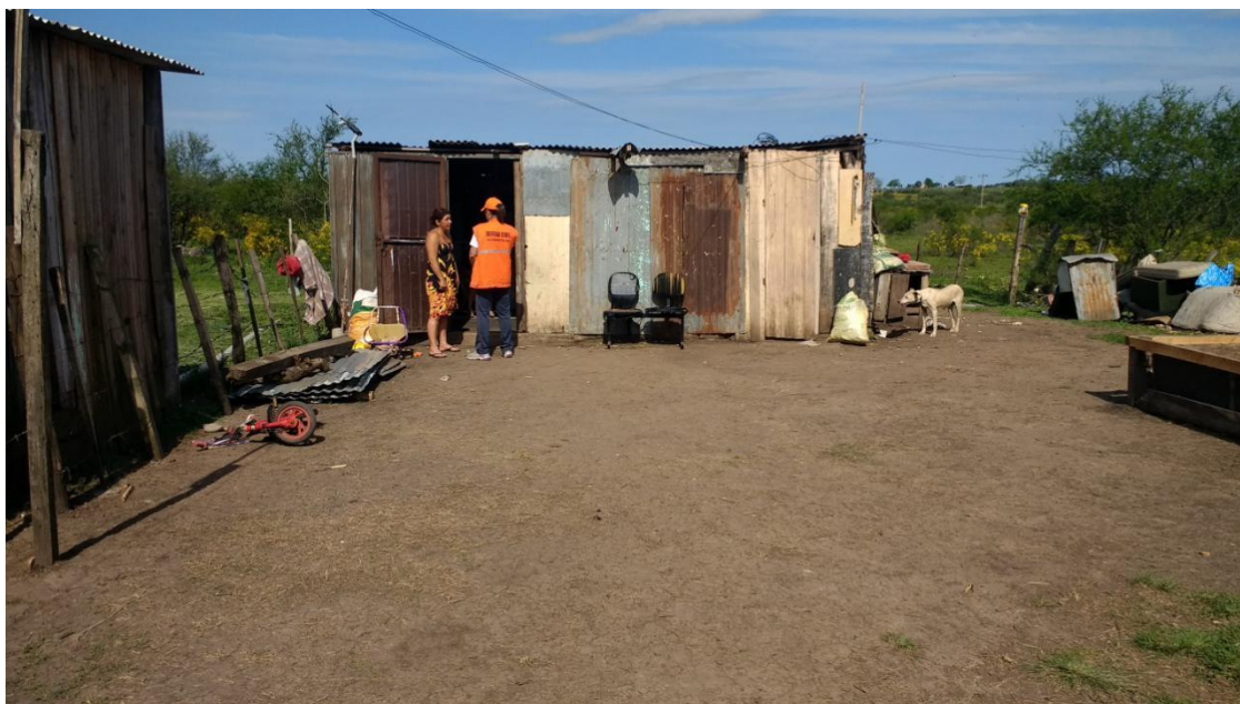
Figura 50 - Moradias afetadas no bairro Renascer.
