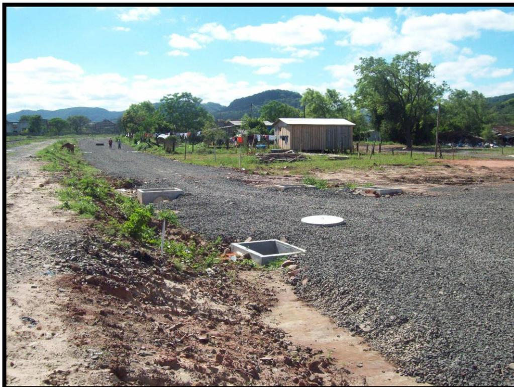
Figura 08: Ligação primária da rede de esgoto sem conexão com as residências.
