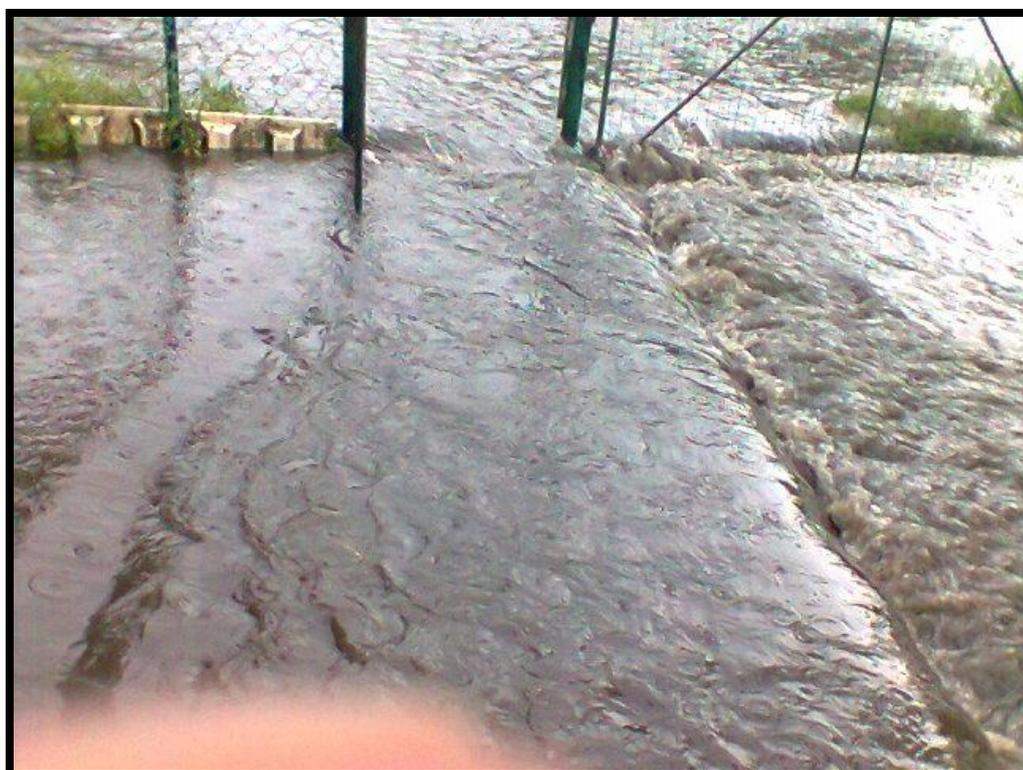
Figura 13: Alagamento causado pela falta de vazão do encanamento que leva a água da chuva até o rio.
