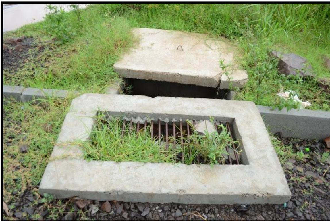
Figura 11: Tampa da rede de esgoto e bueiro em processo de deterioração.
