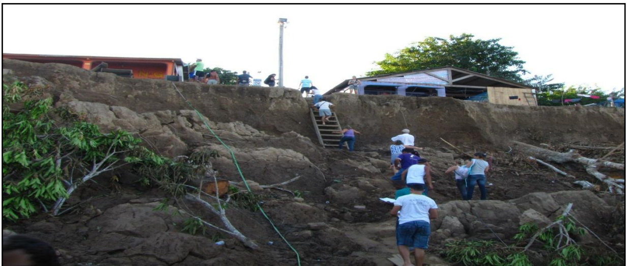
Figura 5 - Vista parcial do local de embarque e desembarque, com sinais evidentes de um escorregamento recente. Na parte superior pode ser observada uma escada improvisada para facilitar o acesso e, uma casa comercial sendo desmanchada
