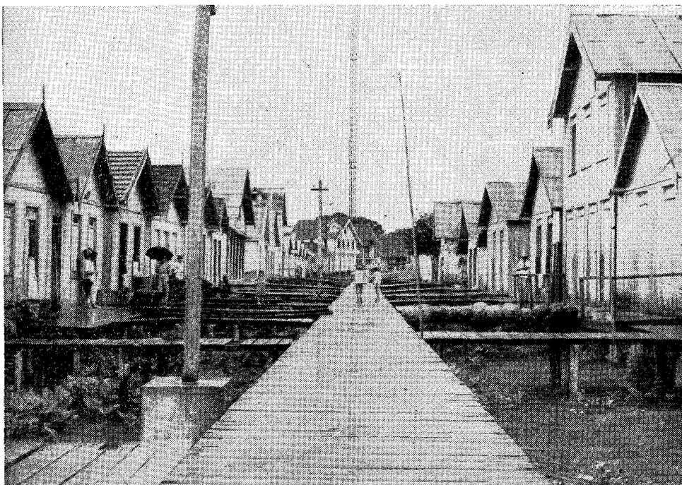
Foto 10 — Aqui o estilo do aglomerado é completamente diferente do das fotos anteriores. Não é necessário, talvez, dizer que é o estilo amazônico: trata-se da localidade de Tarauacá. As casas são de madeira, sobre estacas, os telhados são íngremes para que escorra rapidamente a água das chuvas torrenciais. (Foto CNG. 1 061).
