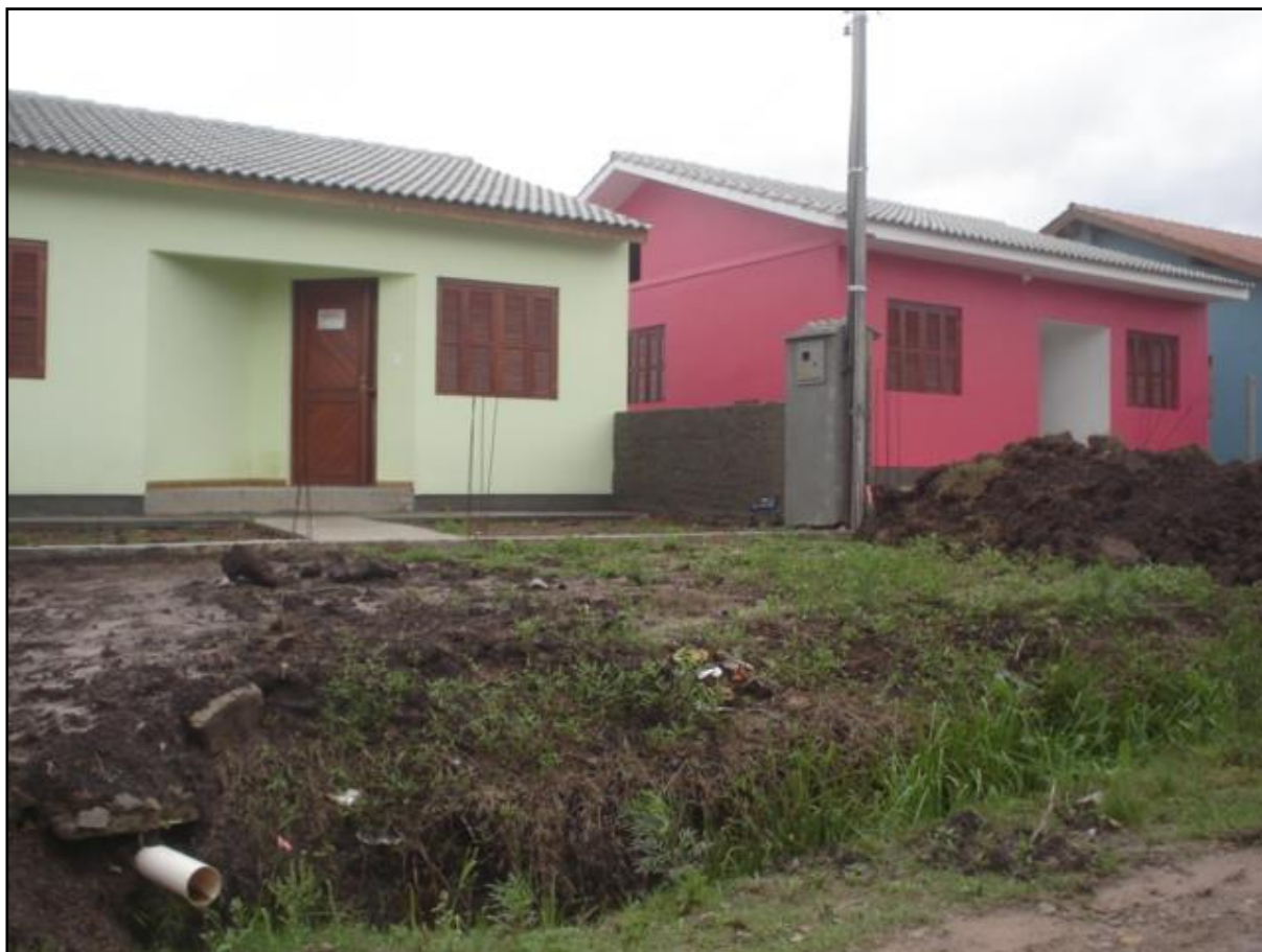
Figura 3 - Falta de rede de esgoto e proximidade das residências no Bairro Pinheiro Machado. Trabalho de campo Nov. 2010.
