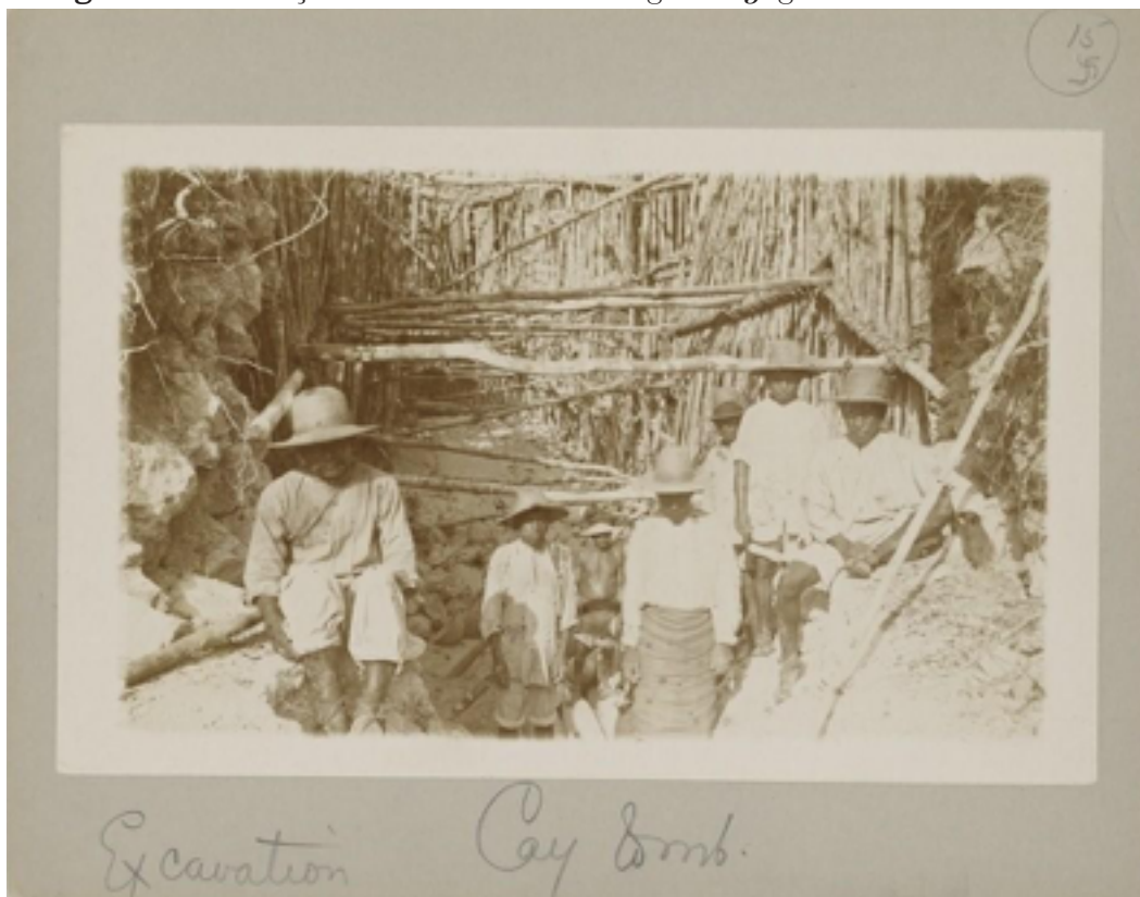
Figura 5. Escavações na Plataforma das Águias e Jaguares em Chichén Itzá.
