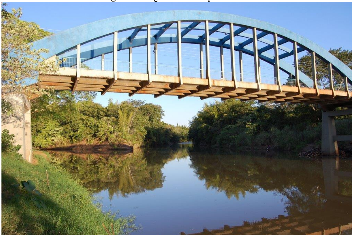
Imagem 5. Imagem atual da “ponte velha” 5 .
