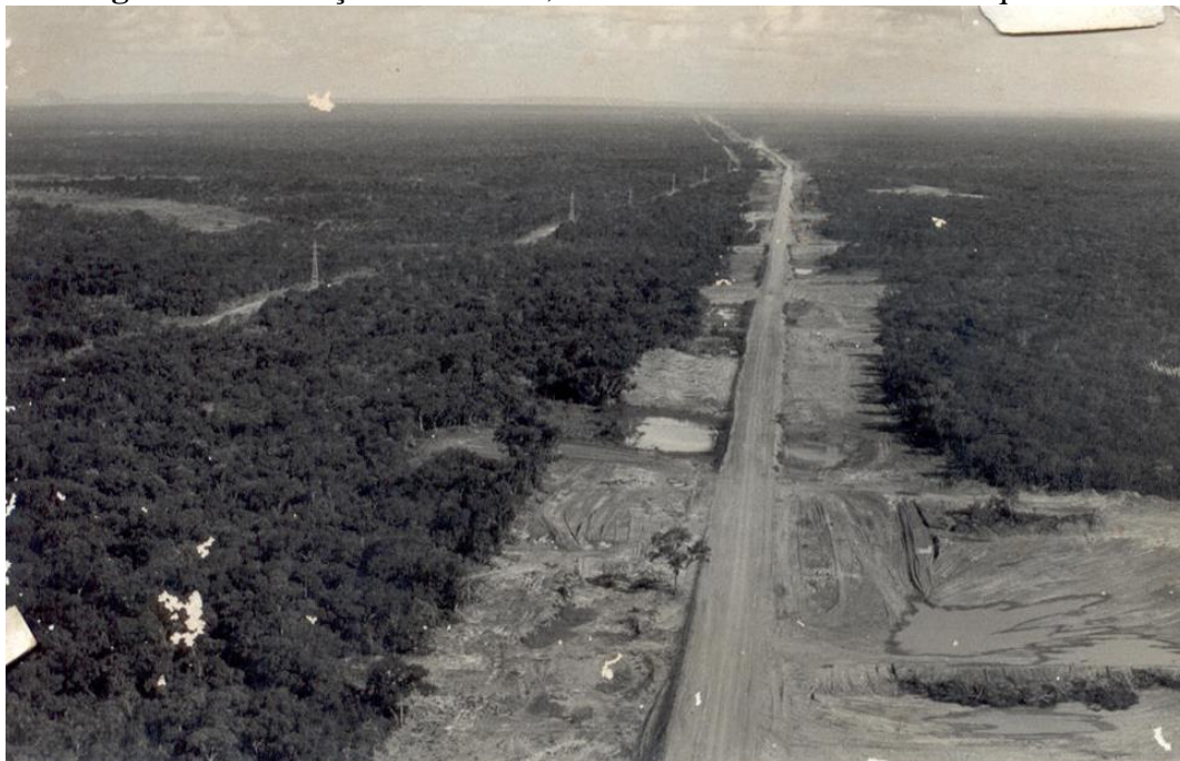
Imagem 8. Construção da BR-262, em 1973. Trecho Miranda - Aquidauana.
