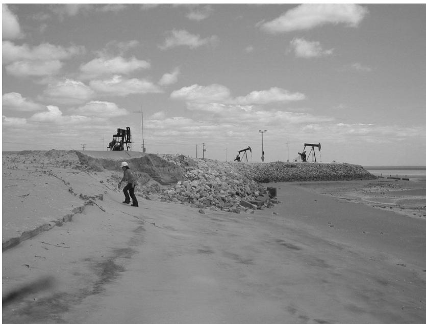
**Figura 5** - Retrogradação ampla da linha de costa colocando em risco os poços de petróleo
