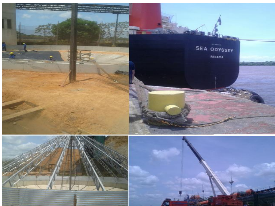
Figura 4: Obras para armazenagem e transporte de grãos em Santana
