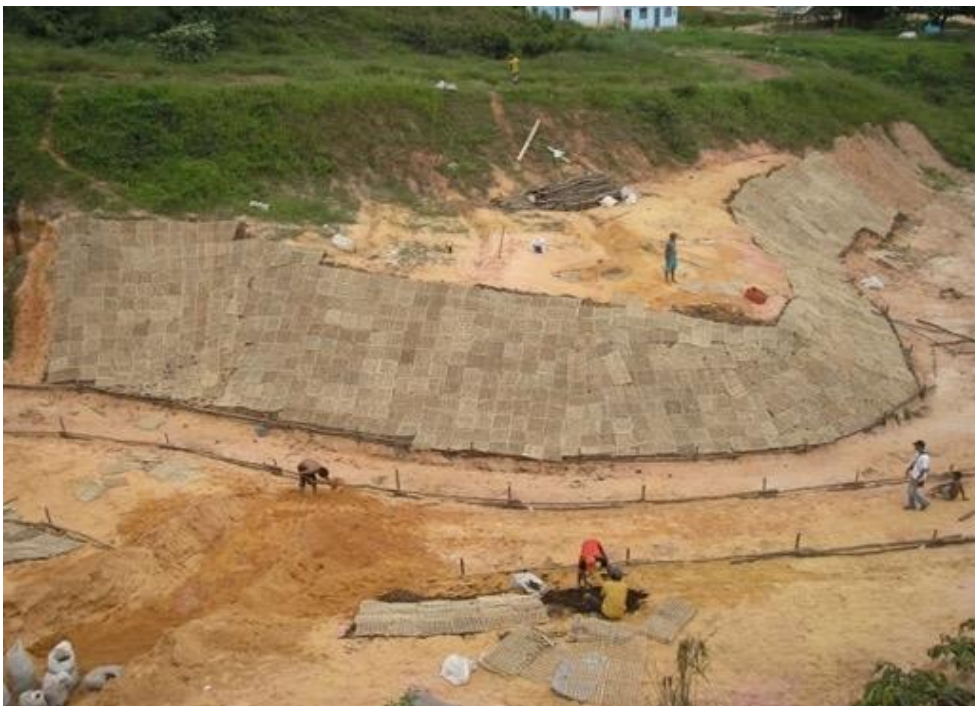
Talude totalmente recuperado, com geotêxteis de buriti, sementes de braquiária, matéria orgânica, NPK e calcário moído. Foto Fernando Bezerra (2008).
