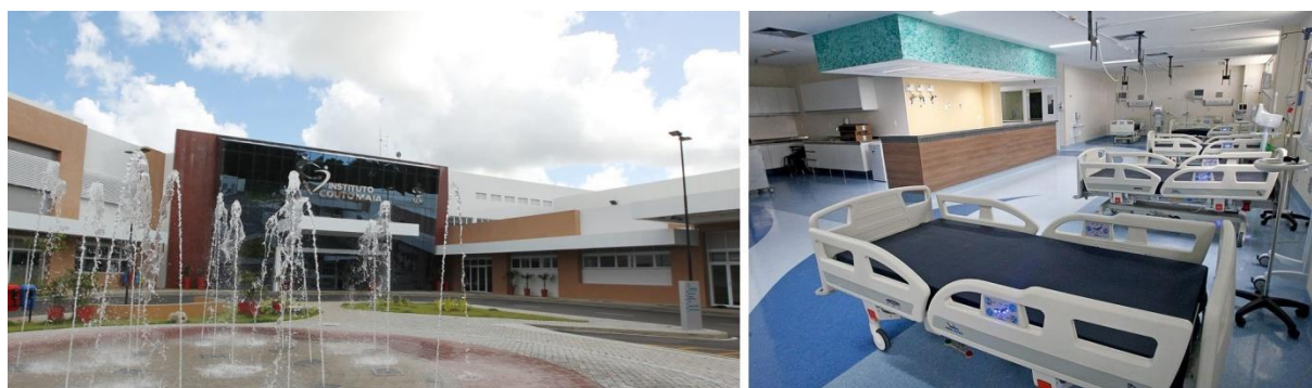
Figura 8 – Fachada e leitos da enfermaria no Instituto Couto Maia
