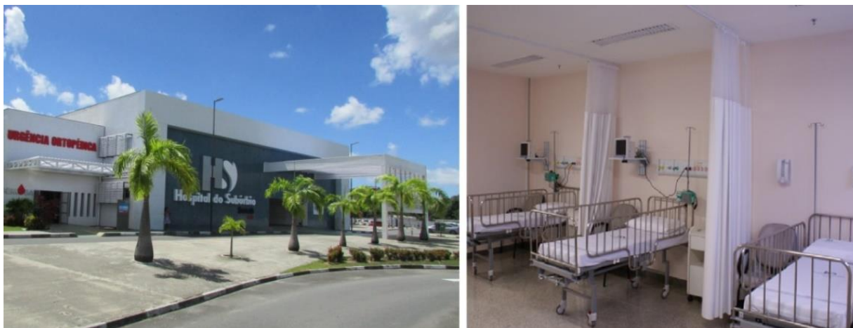
Figura 5 – Fachada e leitos na enfermaria I do Hospital do Subúrbio
