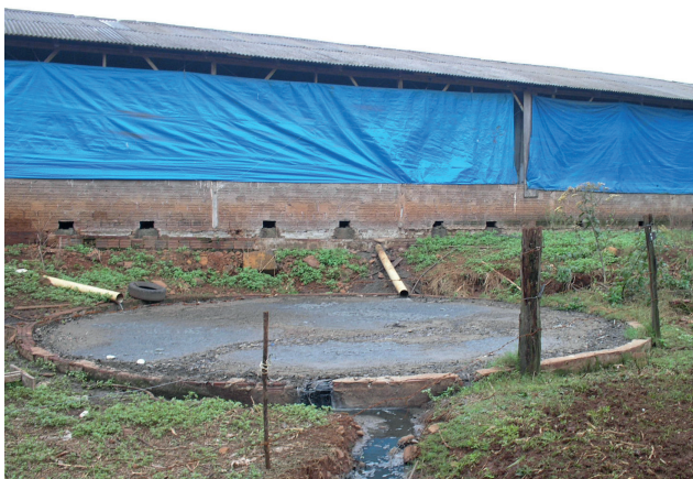
Figura 3. Sistema de armazenamento.
