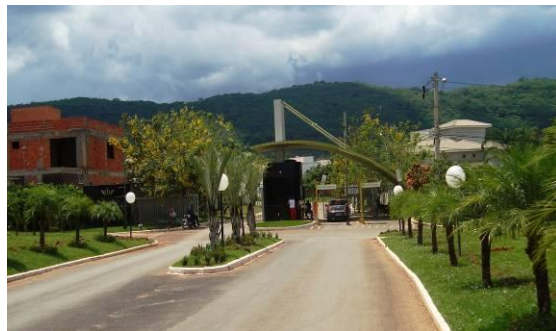
Figura 2: Condomínio Portal das Acácias, Zona Oeste.
