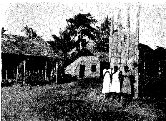
Itamaoari, antigo quilombo, povoado da margem esquerda do Gurupí — um dos portos fluviais para as bacias afluências dos rios "Caramogi" e "Gurupí-Mirim"
