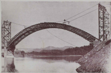
Ponte sobre o Espanto. Montagem das águas, em 11 de julho de 1945.
