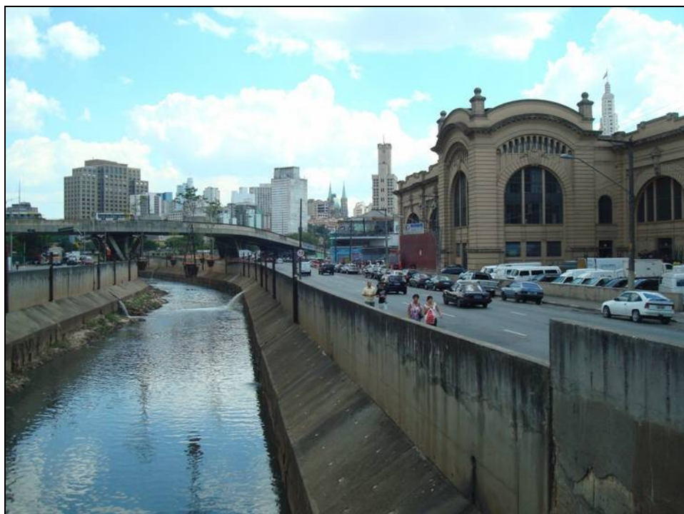
Figura 6: Vista parcial do Mercado Municipal à direita, a partir do encontro das Avenidas do Estado e Mercúrio, em frente ao canal do Rio Tamanduateí. Foto: Ivan Fortunato, novembro/2010
