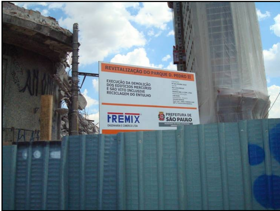
Figura 8: O prédio São Vito, à direita da placa da prefeitura de São Paulo, preparado para demolição. Aqui se observa a lateral do prédio, visto a partir da esquina que une as Avenidas do Estado e Mercúrio com a Rua Luis de Camões. Foto: Ivan Fortunato, novembro/2010.
