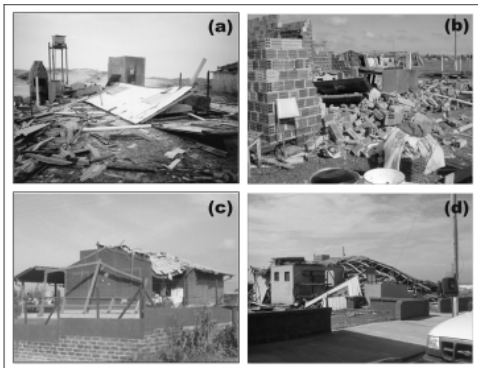
Figura 8 – Exemplo dos danos causados pelo Catarina em diferentes tipos de edificações: (a) casa de madeira; (b) casa de tijolo; (c) casa pré-fabricada; e (d) casa de alvenaria
