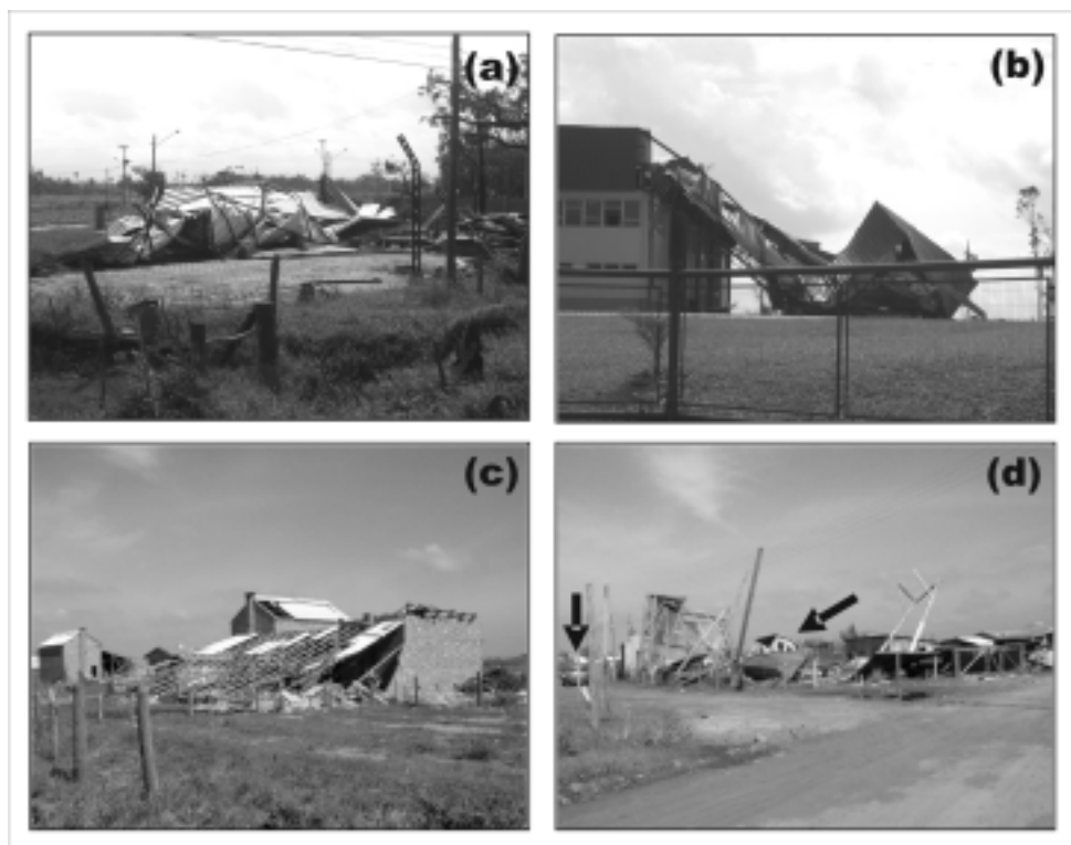
Figura 11 – Tipos de danos causados em galpões: (a e b) destruição parcial e total de galpões de estrutura metálica; (c) destelhamento e colapso de estufas de fumo; e (d) destruição total de estaleiros
