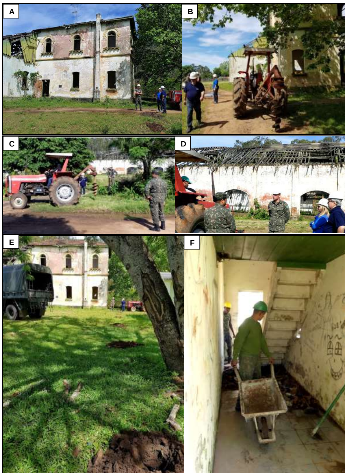
Figura 55 – Início das obras de restauração da Estação de Ferreira, em 2017.
