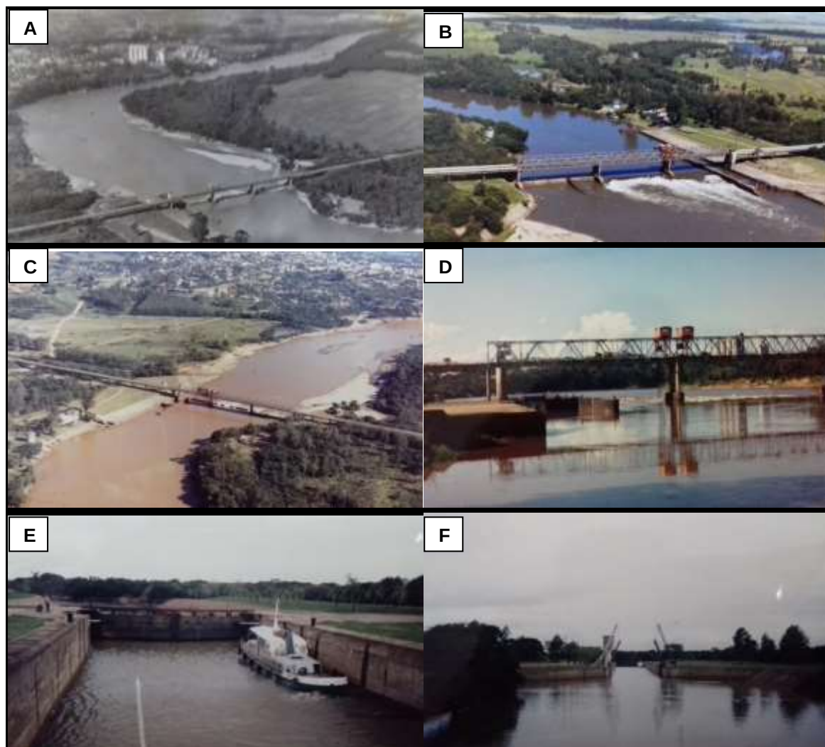
Figura 70 – Estrutura e vista da Barragem Ponte do Fandango.
