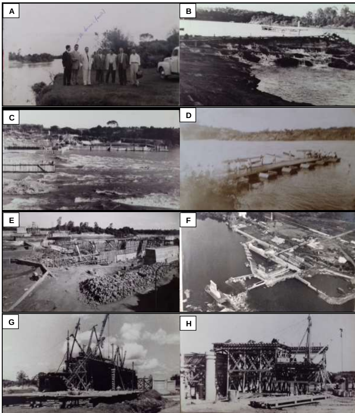
Figura 67 – Obras de construção da Barragem Ponte do Fandango (1956-1975).
