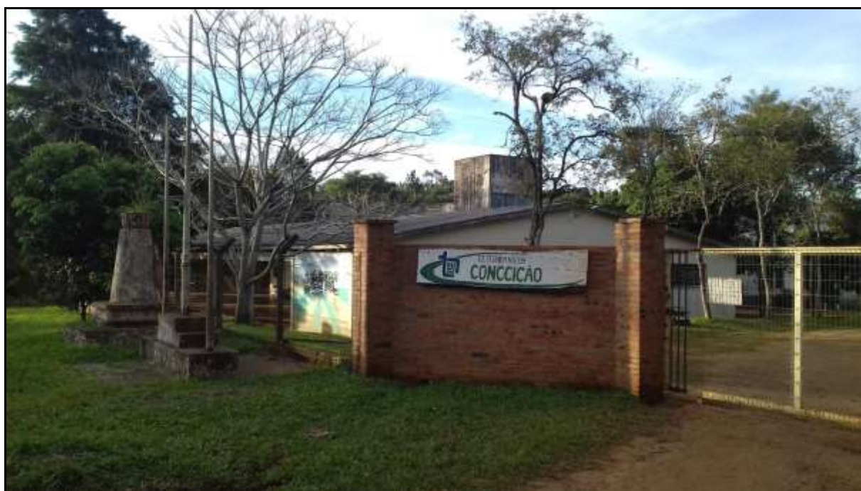
Figura 122 – Escola Técnica Nossa Senhora da Conceição, distrito de Três Vendas município de Cachoeira do Sul, em 2016.
