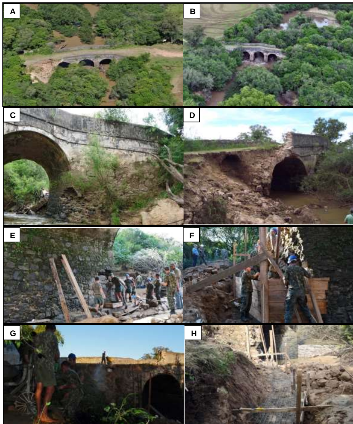
Figura 24 – Ponte de Pedra (2010-2011).
