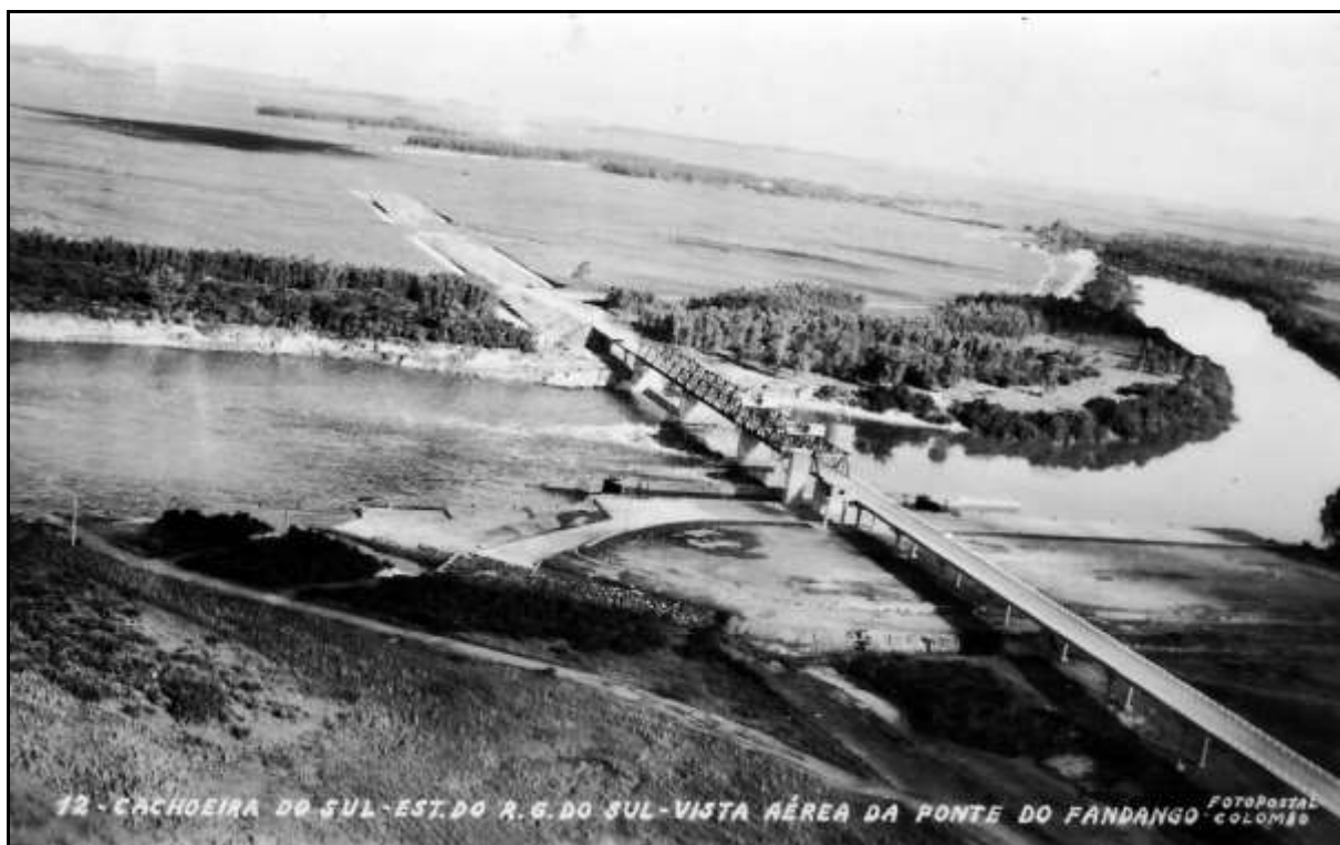
Figura 69 – Barragem Ponte do Fandango sem as vias de acesso na década de 1960.
