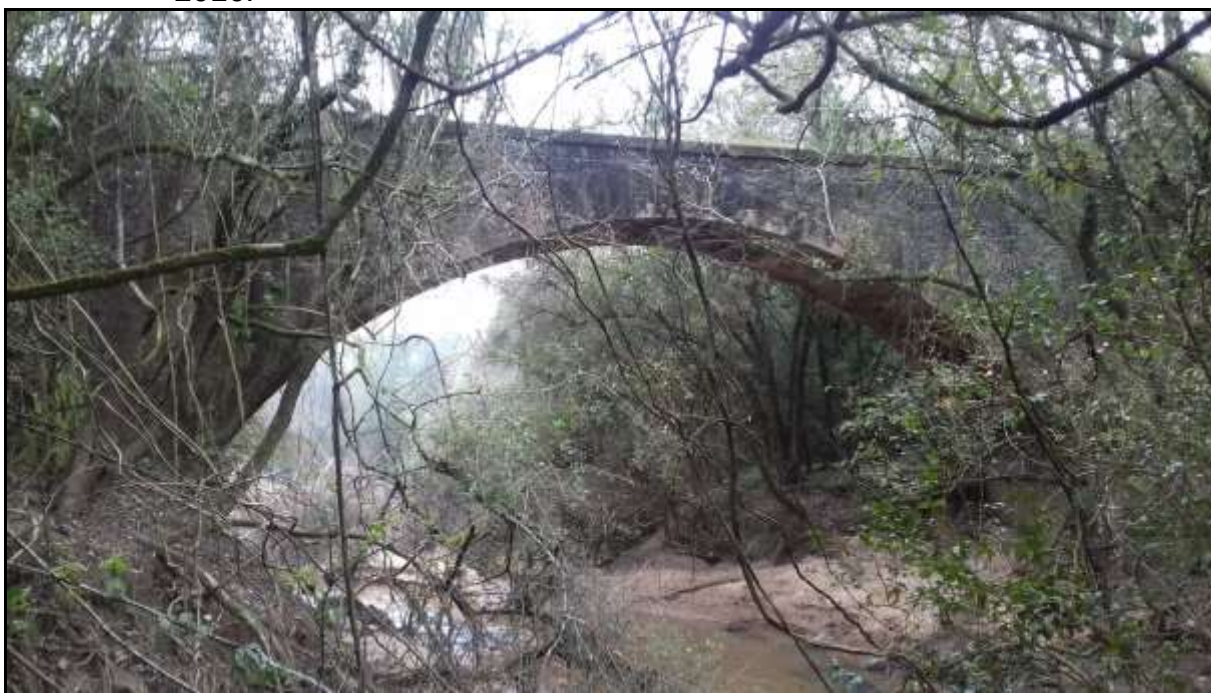
Figura 38 - Ponte Imperial, localidade de Ferreira município de Cachoeira do Sul, em 2016.
