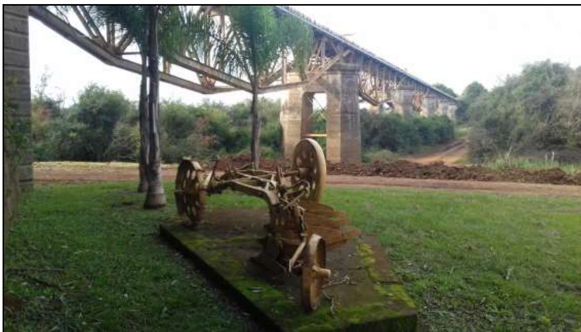
Figura 60 - Ponte Férrea, na localidade de Pertile município de Cachoeira do Sul, em 2016.
