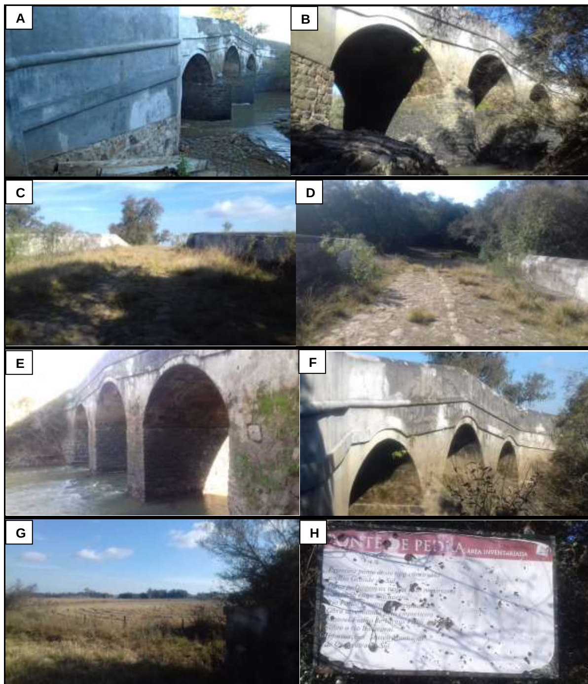
Figura 25 – Ponte de Pedra (2012-2016).
