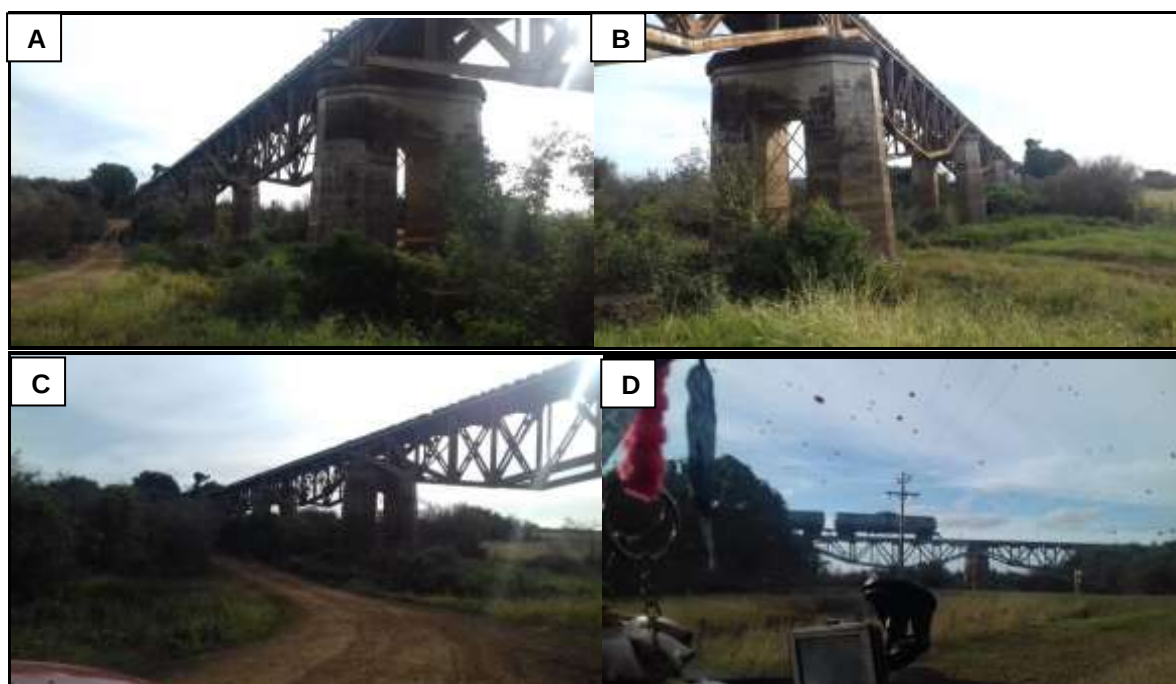
Figura 61 – Estrutura da Ponte Férrea, em 2016.
