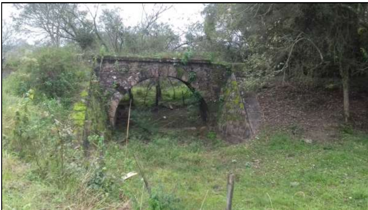
Figura 40 – Pontilhão da Ponte Imperial, em 2016.
