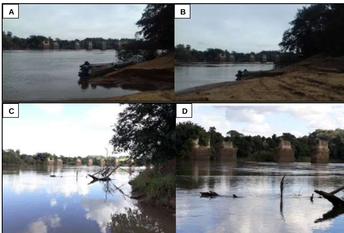
Figura 29: Ponte do Passo do rio Jacuí (2016-2018)
