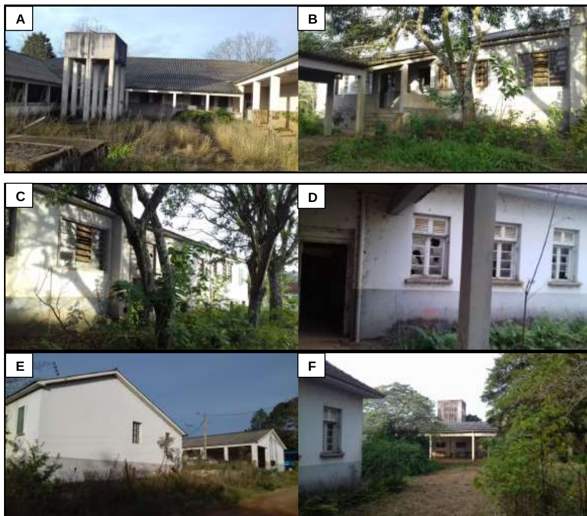
Figura 124 – Instalações do Antigo Colégio Imaculada Conceição, em 2016.
