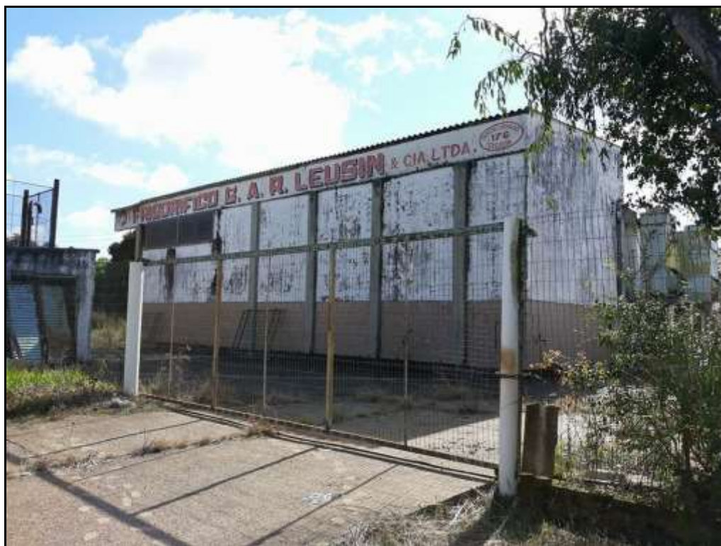
Figura 118 - Instalações do Frigorífico G. A. R. Leusin & Cia Ltda, distrito de Ferreira município de Cachoeira do Sul, em 2018.
