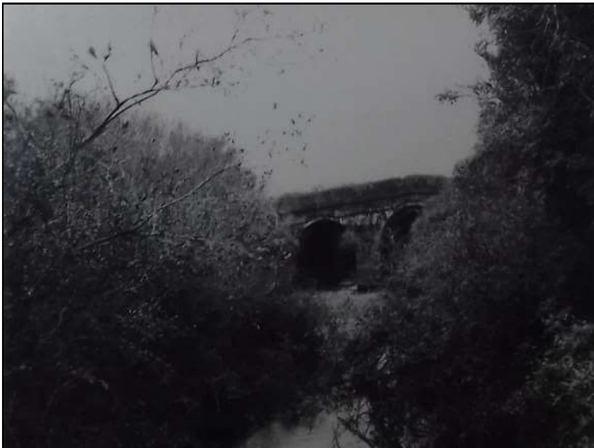
Figura 23 – Ponte de Pedra, em 1989.
