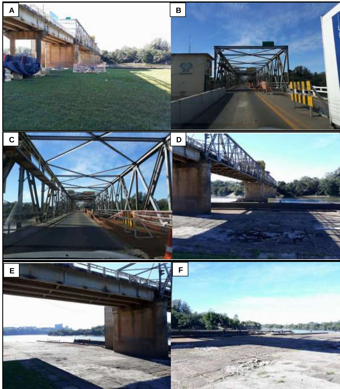
Figura 72 – Obras e Barragem Ponte do Fandango, em 2018.
