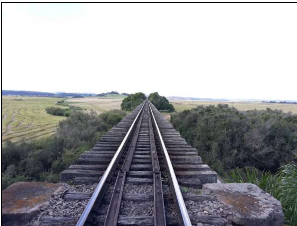
Figura 62 – Trilhos sobre a Ponte Férrea, em 2018.
