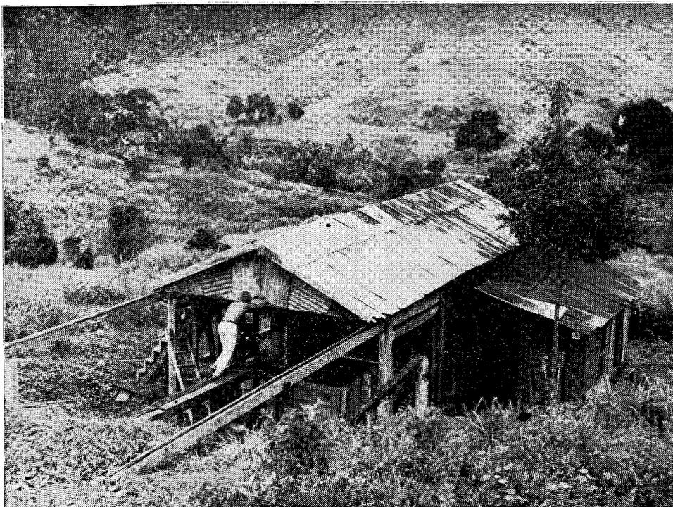
Fig. 6 — A barcaça, com seu teto móvel, destinada à secagem natural do cacau, sendo uma característica única dos edifícios da fazenda de cacau, é a marca do estabelecimento tropical que beneficia o produto para o mercado distante. (Foto T. Somlo — CNG, 1953).
