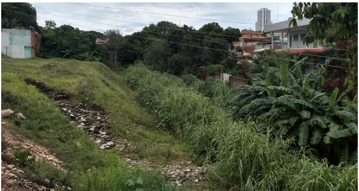
Figura 2: Ravinação na vertente, atingindo o fundo de vale na Avenida República do Líbano. Fonte: Trabalho de campo na Depressão cuiabana. Autor: FONSECA, 2018.
