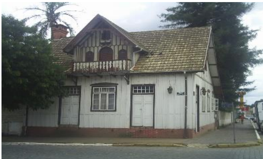
Figura 05 - Residência na região central de canoinhas, construída em 1920.
