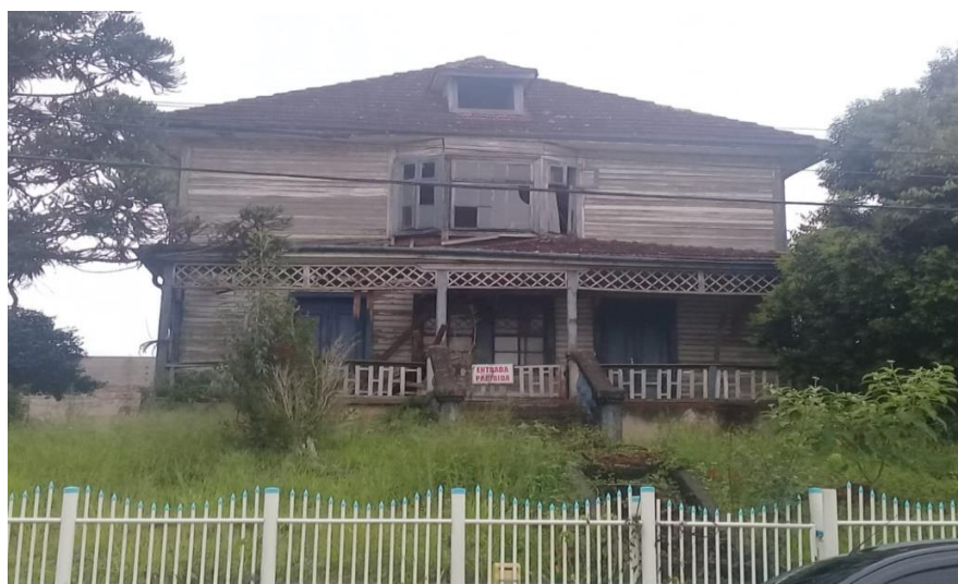
Figura 04 – Residência na região central de canoinhas, construída em 1920
