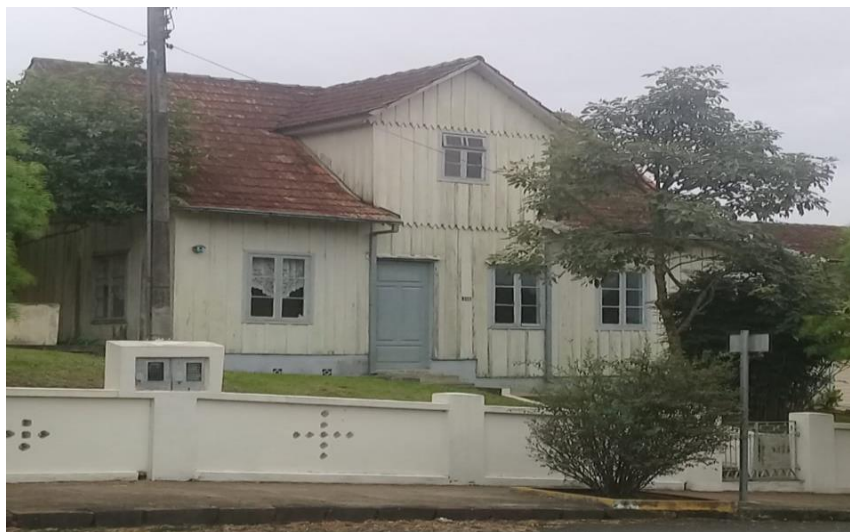
Figura 02 - Primeira moradia do pastor da igreja Luterana, construída em 1920
