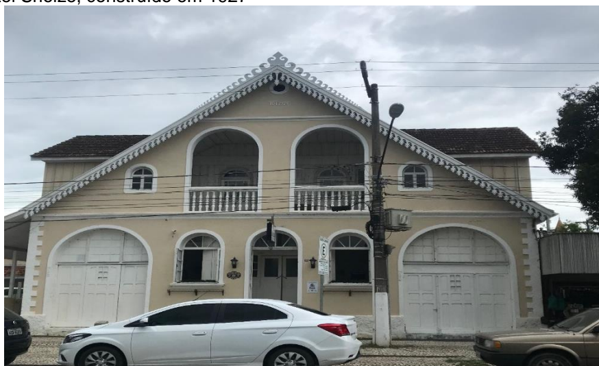
Figura 03: Hotel Sholze, construído em 1927
