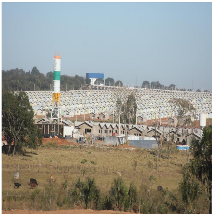
Figura 4: Vista do Residencial Pequís, Uberlândia-MG
