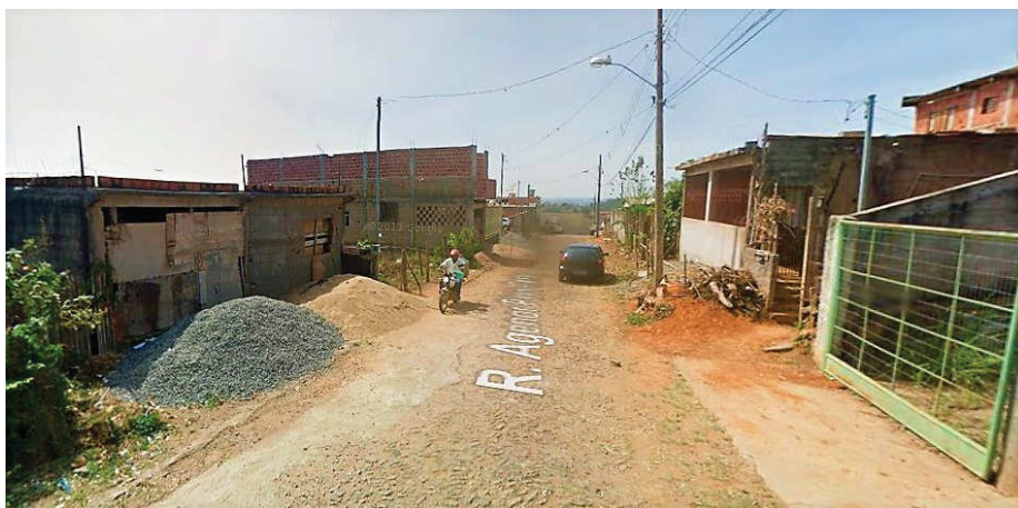
Figura 5 - Presença de materiais de construção nas calçadas de praticamente todas as ruas do bairro Nova Viçosa.
