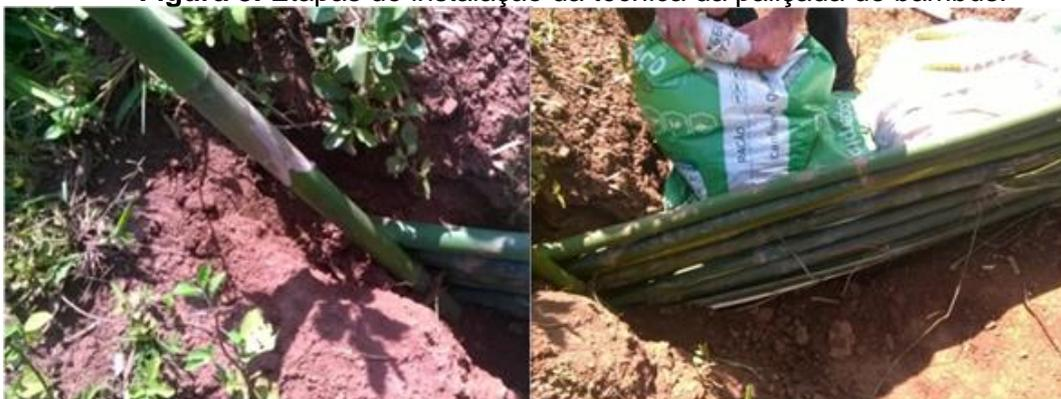
**Figura 4.** Paliçada instalada.
