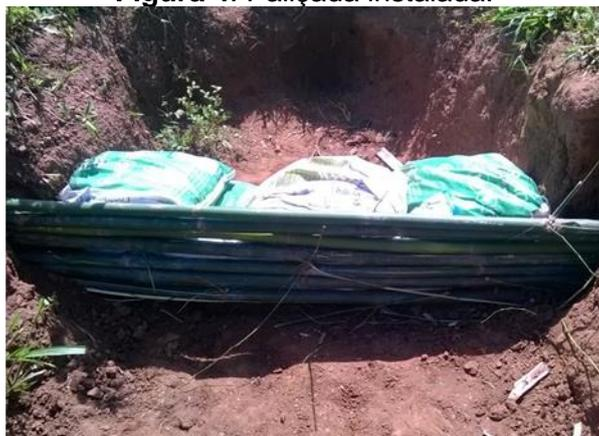
O processo de recuperação da ravina contou com a instalação de três paliçadas de bambus, tendo a primeira (de montante para jusante) 30 cm de altura e posicionada 2 metros antes da cabeceira da ravina, com o objetivo foi o de contribuir com a diminuição da velocidade do escoamento da água. As outras duas, em direção a jusante, já dentro da feição erosiva, tinham 80 cm de altura. A distância entre elas eram de 1 m da primeira para a segunda, e de 3 metros da segunda para a terceira.
