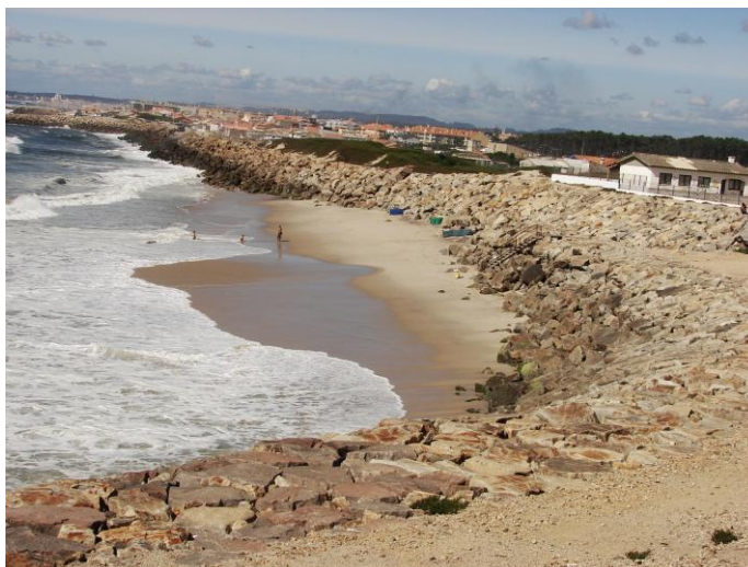
Foto 1: A artificialização do litoral com a construção de obras de protecção
