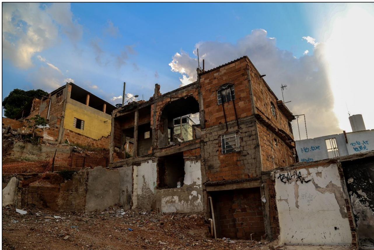
Figura 3 - Casa na vila Arthur de Sá, durante processo de demolição pela PBH para a construção da via 710
