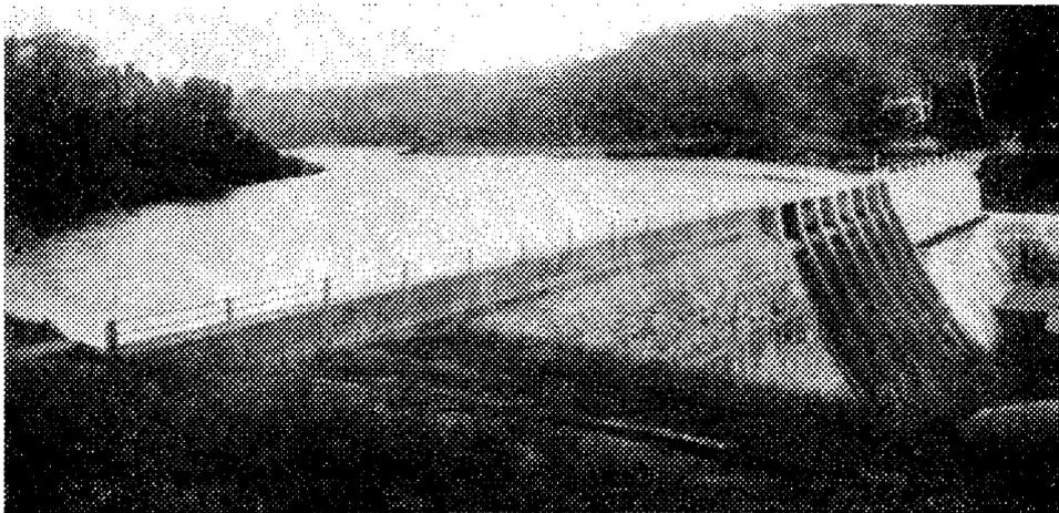
Fig. 2 — Barragem do rio Cobre com 141 metros de comprimento e 18 de altura. Armazena 2.340.000 metros cúbicos d'água
