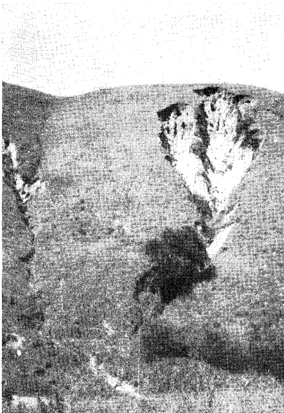
Fig. 9 — A cobertura deficiente dessa pastagem e as características físicas do seu solo, bastante favoráveis a esse tipo de erosão permitiram o desenvolvimento dessa grande voçoroca e o início da menor ao lado.
