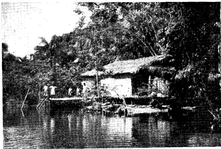
Fig. 4 — Habitação construída com material exclusivamente vegetal (teto e paredes de fôlha de palmeira; estrutura de troncos de árvores), na ilha Grande de Gurupá.
