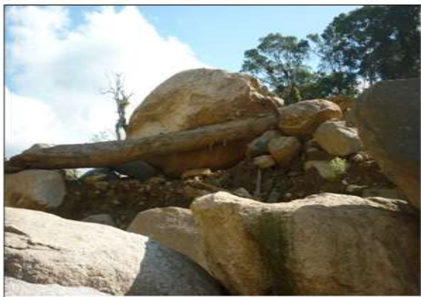
Figura 13: Leque com conjunto de grandes blocos de rochas instáveis no alto curso do Rio Tingidor, visão à montante, demonstrando que muito material ainda pode descer vertente abaixo. O tamanho dos blocos indica que possivelmente os impactos ocasionados pelo desprendimento e posterior rolamento, pode ter desencadeado outros processos de movimentos
