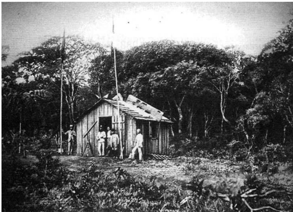
Figura 6: Observatório no vértice NO
