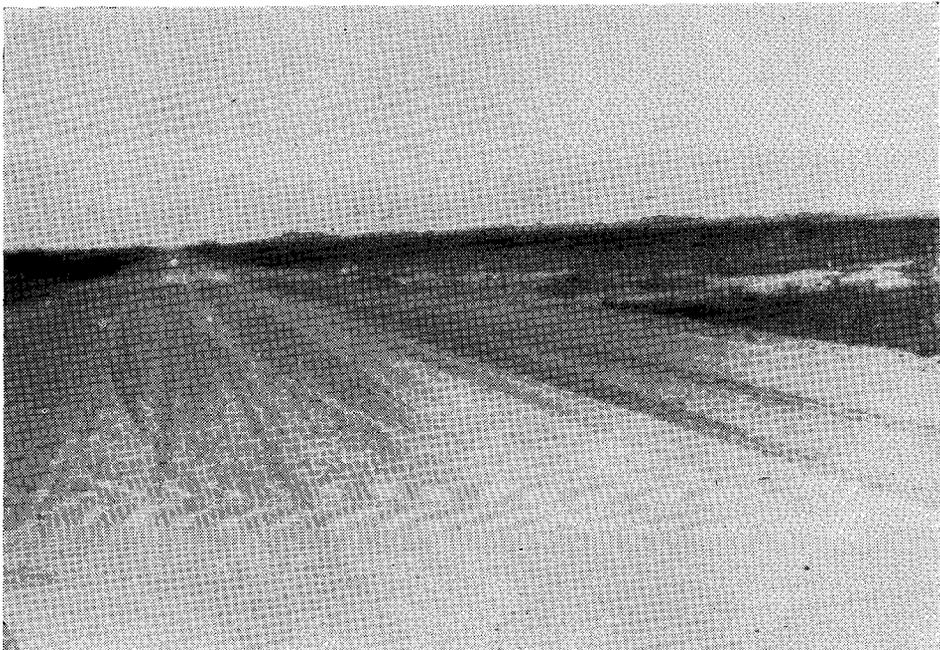
Foto 21 — Trecho da mesma estrada, em pleno campo. Observa-se que o leito desta foi estabelecido no mesmo nível e, em certos pontos, inferior ao do campo. Em consequência, durante as chuvas, a estrada fica impedida pelo encharcamento do solo argiloso.
