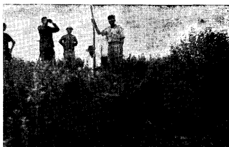
Foto 32 — O giro do horizonte, perscrutando e procurando identificar as serras que se desdobram na área do Alto Ribeira, constituía sempre a operação preliminar, ao ser atingido o topo das elevações colimadas. Procedimento na serra de Santana. Note-se o revestimento subarbusivo do cume.
