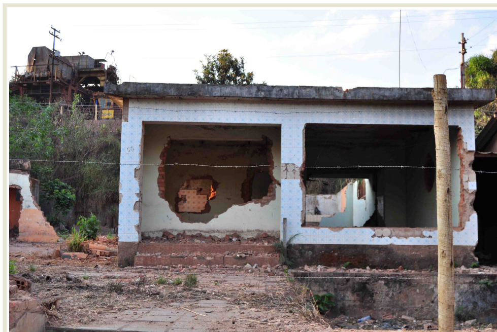
FIGURA 4 - EDIFICAÇÃO DESAPROPRIADA E PARCIALMENTE DEMOLIDA PELA CSN
