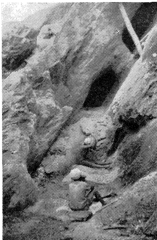
Itapicurú. Níveis de conglomeratos, mergulhando fortemente para leste, são arrancados a explosivo, mistura de clorato e açúcar, reduzidos a pó e bateados.
