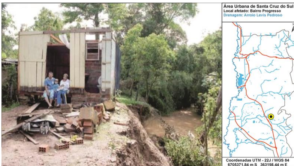
Figura 49 - No bairro Progresso, residências foram danificadas após chuvas intensas. Fonte: Portal Gaz, 21/11/13
