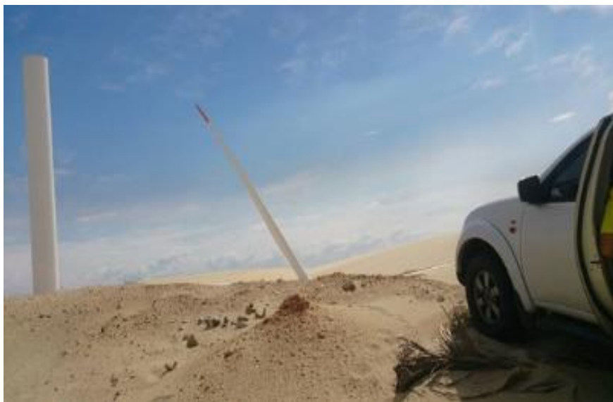
Figura 2: Destruição de campo de eolianitos em Flecheiras (Ceará) visando a instalação de turbinas para produção de energia eólica, com autorização do órgão ambiental estadual.
