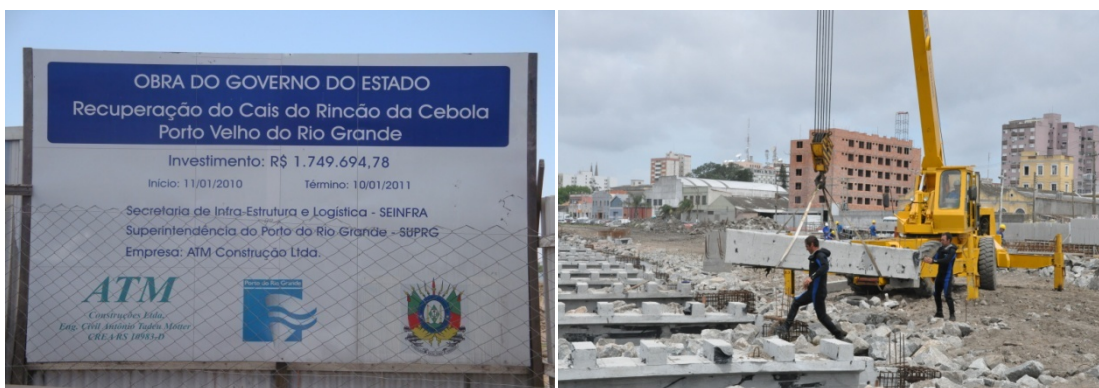
Figura 18. Construção do cais no setor oeste (início das obras no Rincão da Cebola)
