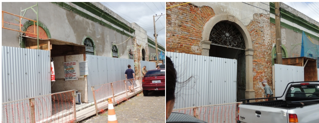
Figura 36. Detalhes da restauração da fachada do Mercado Público Municipal
