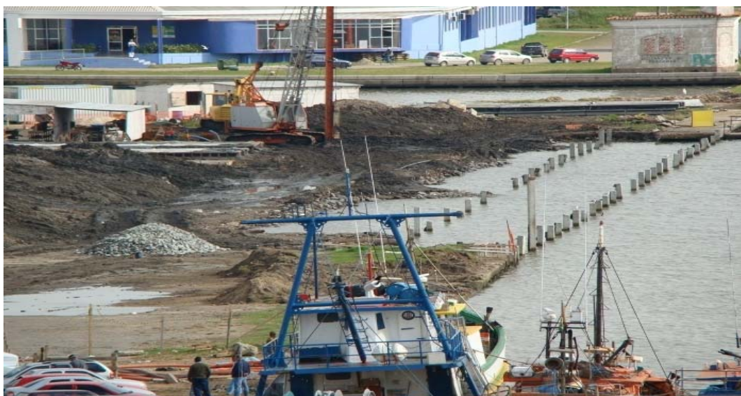
Figura 9. Prédio revitalizado que abriga o CCMAR, com o início das obras no setor oeste.
