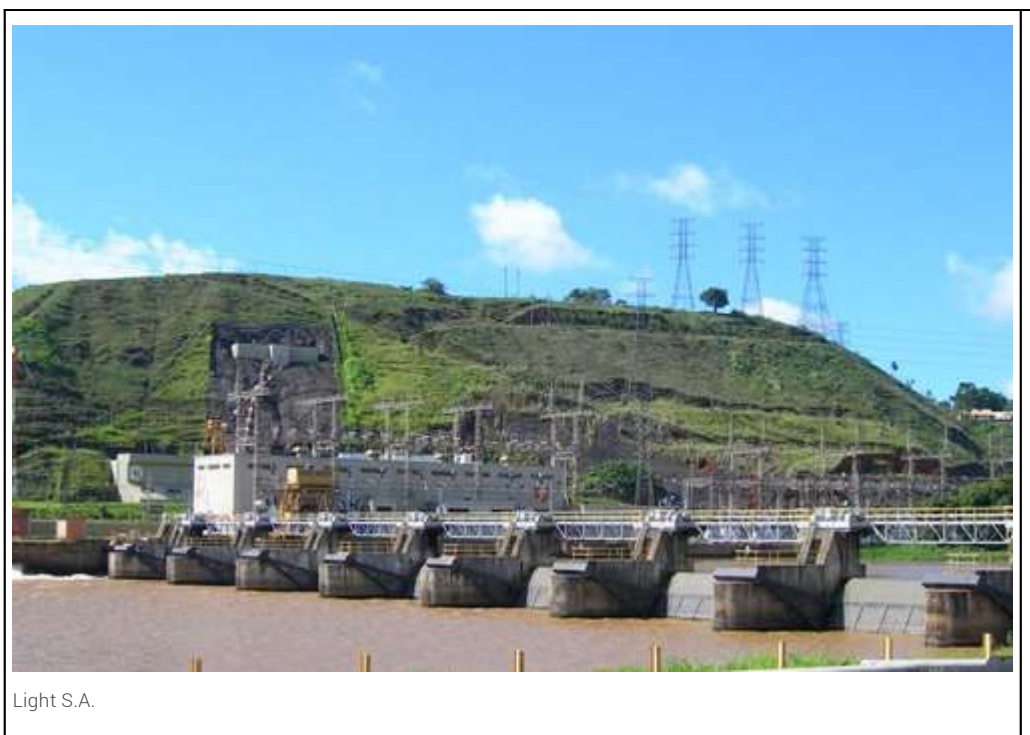
Foto 5. Estação captadora e bombeadora de Barra do Piraí
