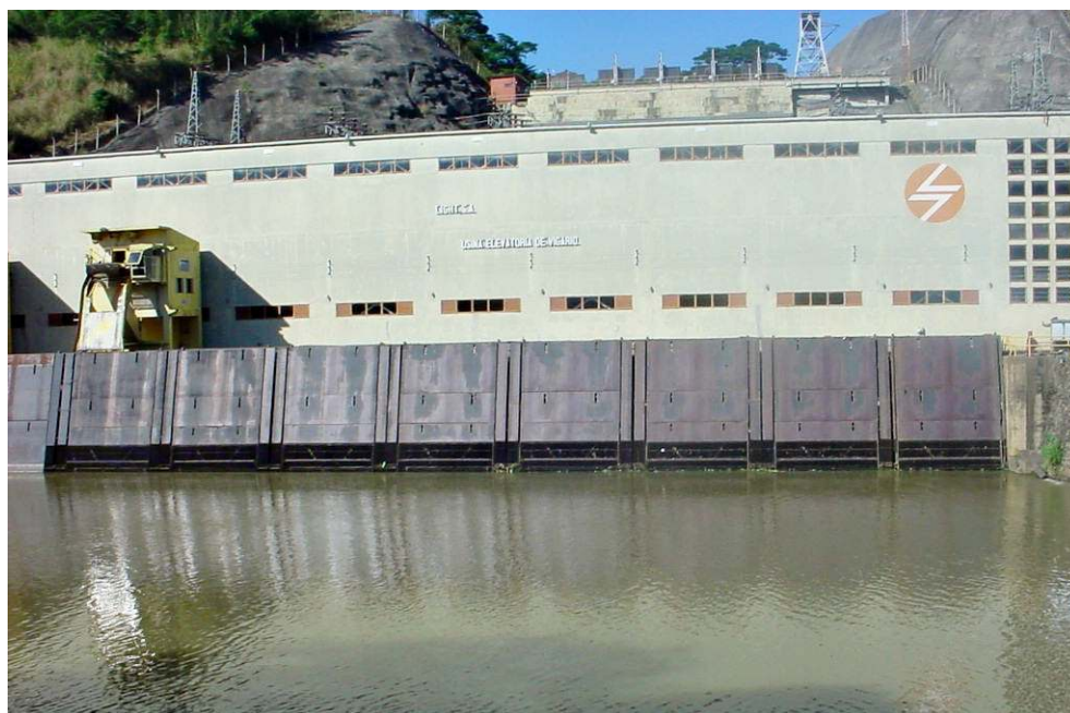
Foto 6. Estação Elevatória de Vigário, em Piraí.
