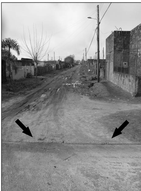
**Figura 11 – Detalhe do desnível entre as ruas S e E**
