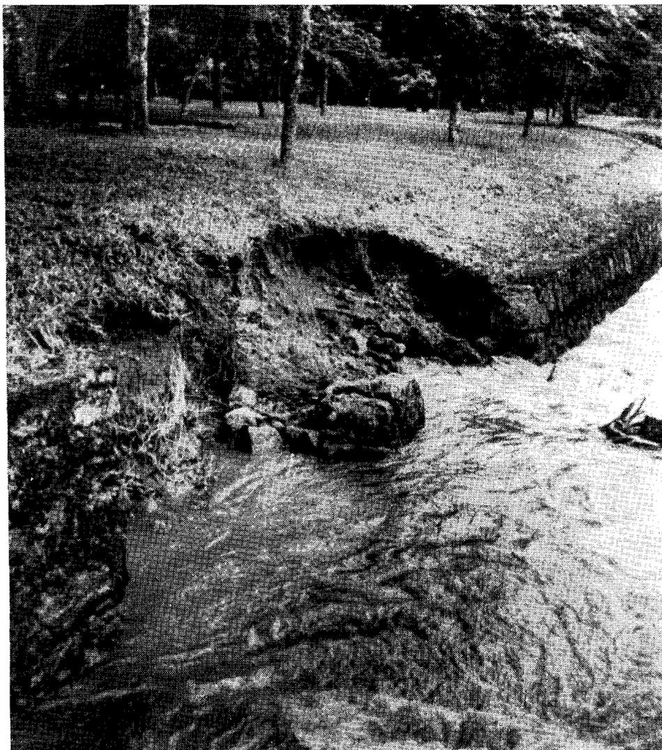
Fig. 3 — Rio dos Macacos — Rio de Janeiro. Efeito das águas das enchentes causadas pelos temporais de verão, nas margens já canalizadas do rio dos Macacos, na altura do Jardim Botânico. As águas solapam a muralha causando o desbarrancamento das margens do rio, como se pode notar na fotografia. O rio dos Macacos desce da serra da Carioca para a lagoa Rodrigo de Freitas.
