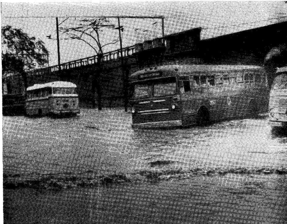
Fig. 5 — Ponte dos Marinheiros — Rio de Janeiro. Um dos trechos da cidade mais atingidos pelas enchentes é a praça da Bandeira e imediações, zona de drenagem verdadeiramente difícil. As comunicações ficam interceptadas, como se pode ver na fotografia, tirada no local da Ponte dos Marinheiros e travessia do viaduto da Estrada de Ferro Central do Brasil.
