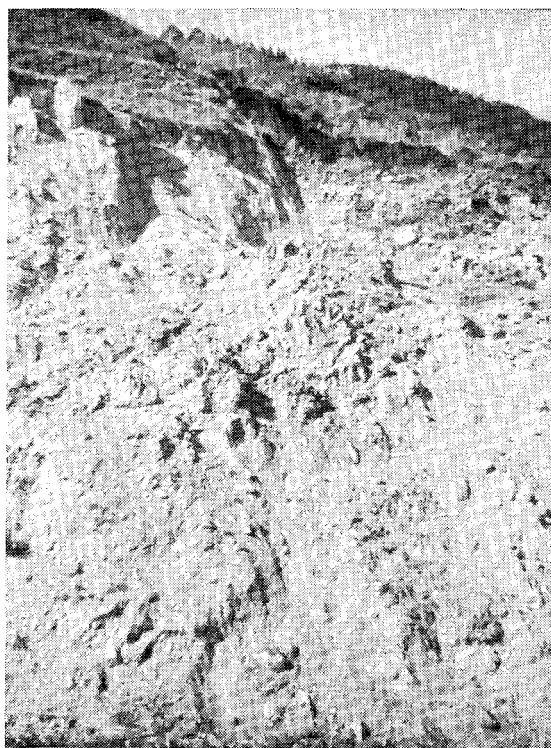
Erosão "corrida de terra" ou "escorregamento", corte da Rodovia SP-123, Taubaté-Campos do Jordão, SP.
