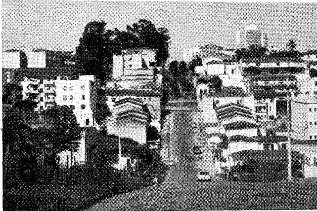
Foto 10 — Rua Alves Guimarães, em Cerqueira César. Inadequação da planta (tabuleiro de xadrez) às condições topográficas. No trecho de maior declive a pista de rodagem se vê interrompida, sendo possível apenas a travessia de pedestres através de escadarias.
