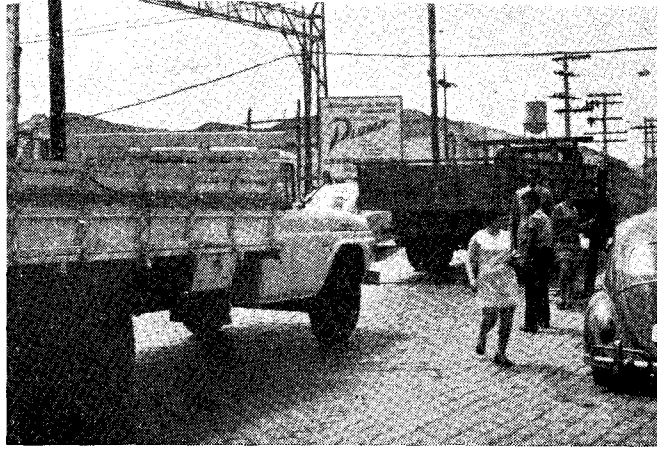
Foto 15 — Porteiras da Rua Silva Jardim: precário meio de transposição da linha da E. de F. Central do Brasil no bairro do Belém. Tais passagens de nível ainda são numerosas em São Paulo, embora estejam sendo gradativamente substituídas por viadutos.
