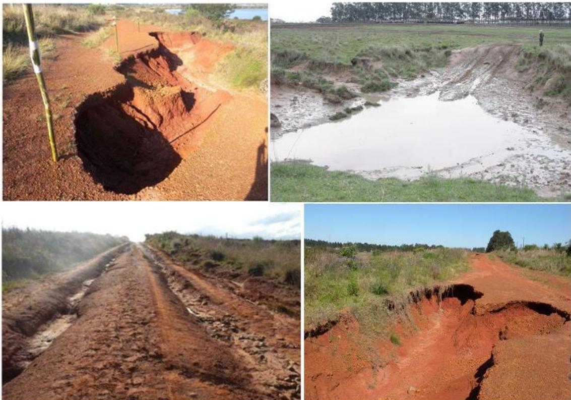
Figura 25 – Processos erosivos que ocorrem no CISM
