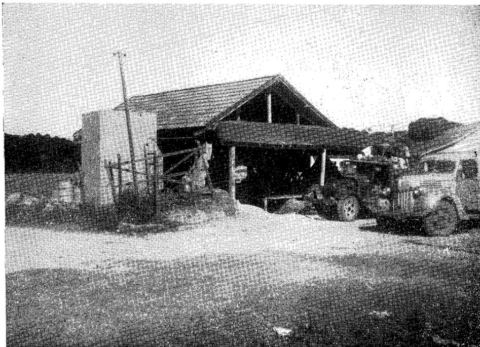
Foto 9 — Olaria “Fontinha”, Nova Cidade, Nilópolis. Focaliza-se aí o meio de transporte empregado nas olarias médias e pequenas. Os caminhões trazem a “tabatinga” do “barreiro” até o “picadeiro”.
